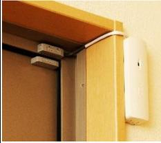
開閉センサー( ライフリズム監視 )<br>( P.5 図⑤ ) | トイレなどの扉に設置する、開閉を感知するセンサーです。一定時間センサーが反応しなかった場合は、ガードセンターへ通報され、ガードマンが駆けつけます。                                          |
